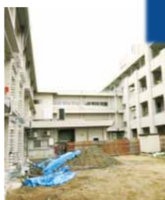
耐震工事の進む校舎
