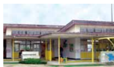
耐震化が急がれる保育園舎
