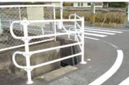
通学路の転落防止柵（大門町）
