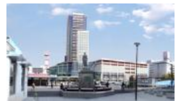
伏見町地区第一種地再開発事業。
