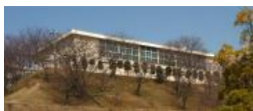
耐震構造で建て替えられた 鳳中学校の体育館
