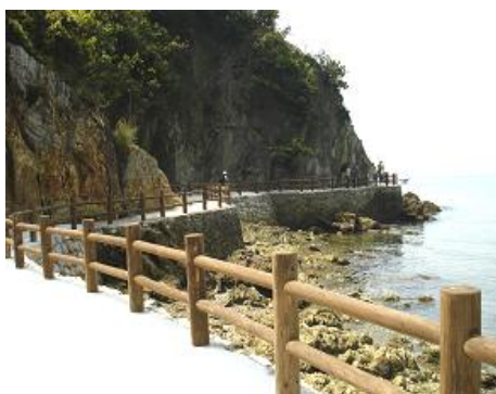
仙酔島遊歩道の復旧
