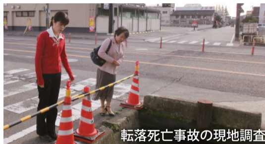
福山市の水路・側溝転落事故
