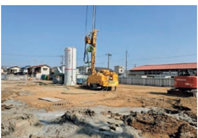
着工した光交流館(光学区まちづくりラボHPより)
