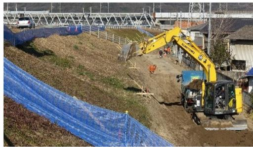
住宅側の堤防のり面。堤防内部にたまる水をスムーズに抜き、崩れないようにする「ドレーン工法」とのこと。(本庄地域)
