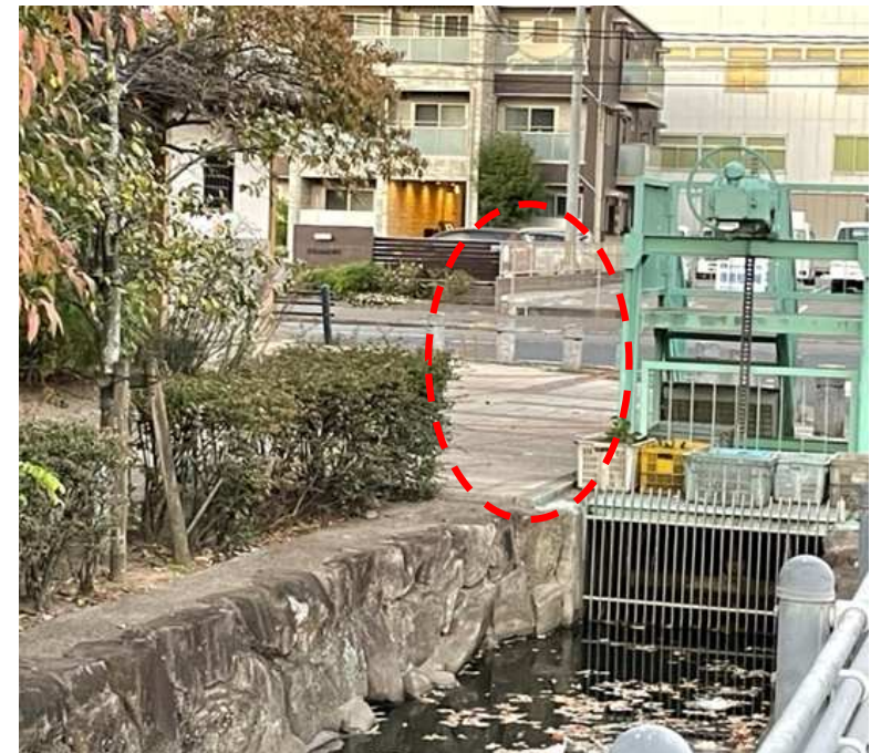
【樋門と生垣の隙間】
