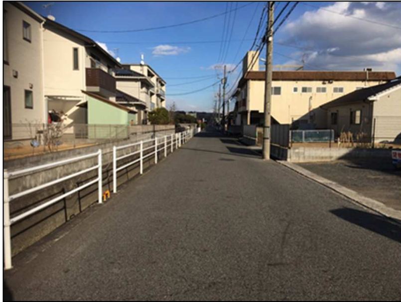
事例1: 転落防止柵
